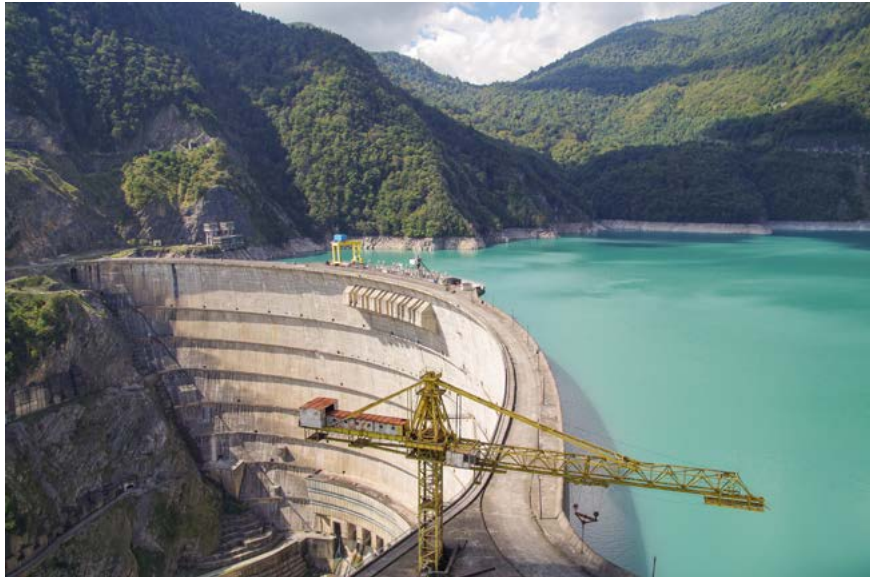
The Enguri Dam is the world's second-highest concrete arch dam on the Enguri River. Tsalenjikha, Georgia ენგურპკისი მდინარე ენგურზე - მსოფლიოში მეორე ყველაზე მაღალი თაღოვანი კამხალი. ნალენჯისა, საქართველო
